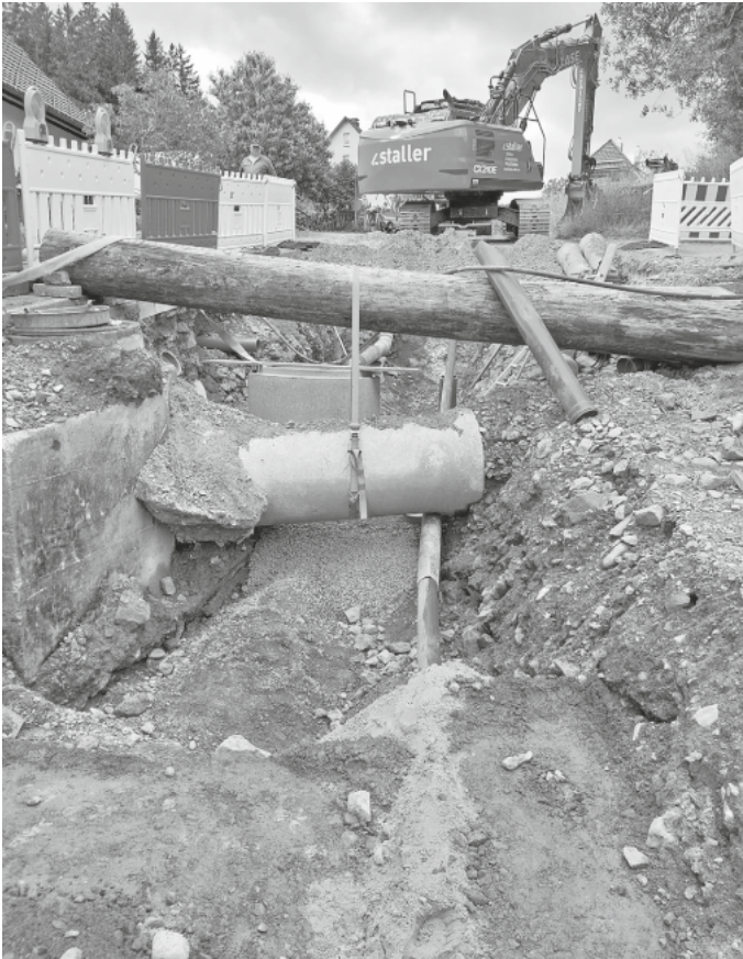
Die Umleitungsstrecke Fuchsfarm/Schmalzbühl steht bevor.
